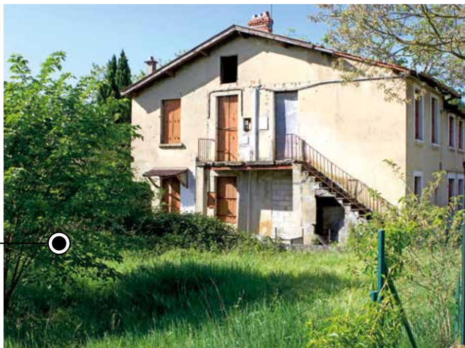
La maison abandonnée en lieu et place du 110 rue de la République sera démolie cet été.
