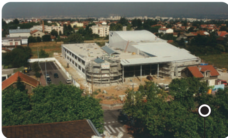
Le Toboggan en construction. Le chantier a duré vingt et un mois.
