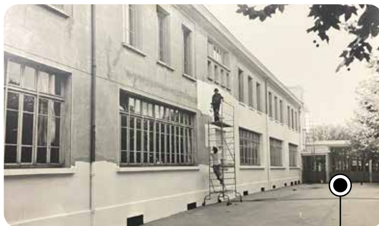
À l'école Jean-Jaurès (anciennement école de la Mairie), des tranchées avaient été creusées de chaque côté de l'établissement pour permettre aux enfants de se réfugier pendant les bombardements.
