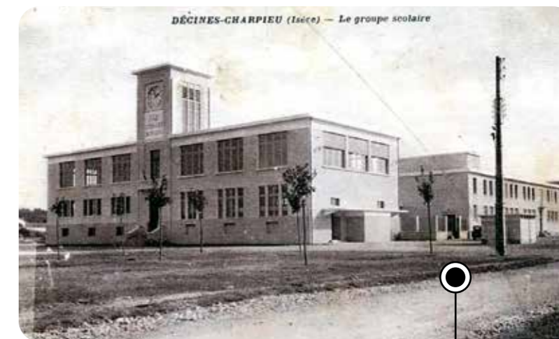
Le nouveau bâtiment de l'hôtel de ville est inauguré en septembre 1932.
