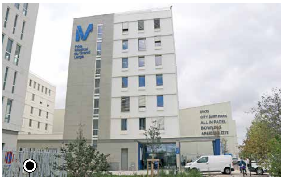
Ouvert suite à la fermeture de la Clinique du Grand Large, le pôle médical Grand Large OL City permet de maintenir une offre de soins conséquente à Décines-Charpieu.
