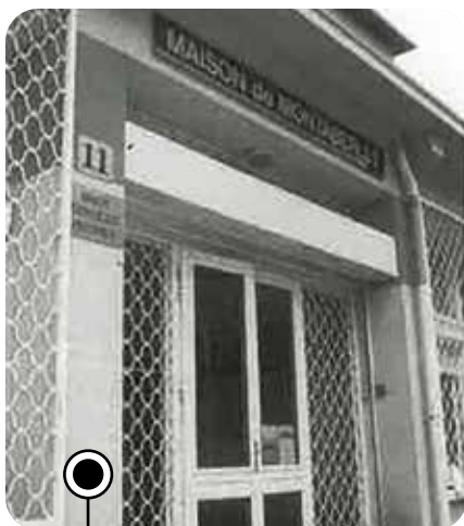
Située au 11 avenue Jean Jaurès, la Maison de l'Emploi regroupe un grand nombre de structures intervenant sur Décines-Charpieu.
