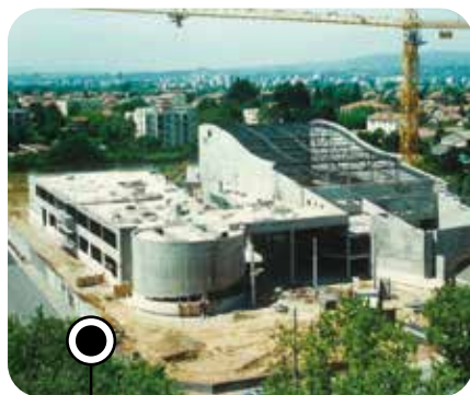
Chantier du Toboggan, en mai 1994.
