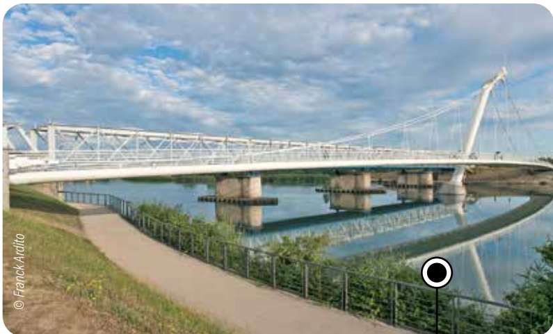
La Passerelle de Décines-Charpieu, dédiée aux modes doux de circulation, est inaugurée en juin 2013.
